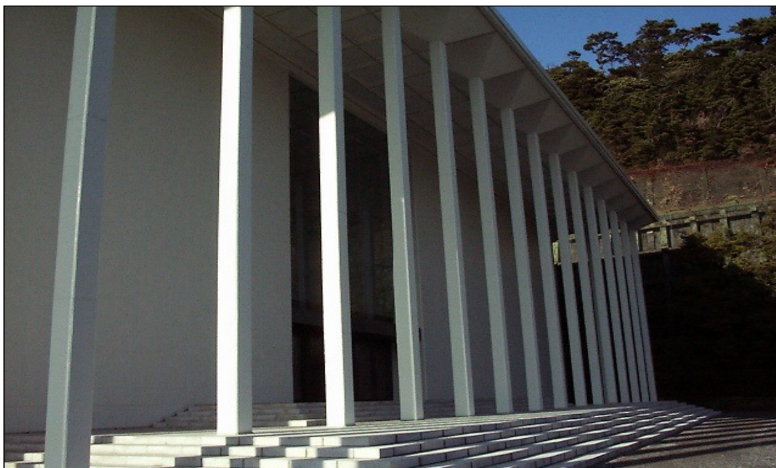
Templo Messiânico no Zuiun-kyo, o Protótipo do Paraíso Terrestre em Atami
